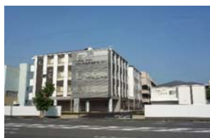
みずしま総合福祉センター ・介護付有料老人ホームなのはな ・グループホームこもれび ・みどり荘在宅介護支援センター ・みどり荘ホームヘルパーステーション ・みどり荘短期入所生活介護事業所さきり ・小規模多機能ホーム あさがお
